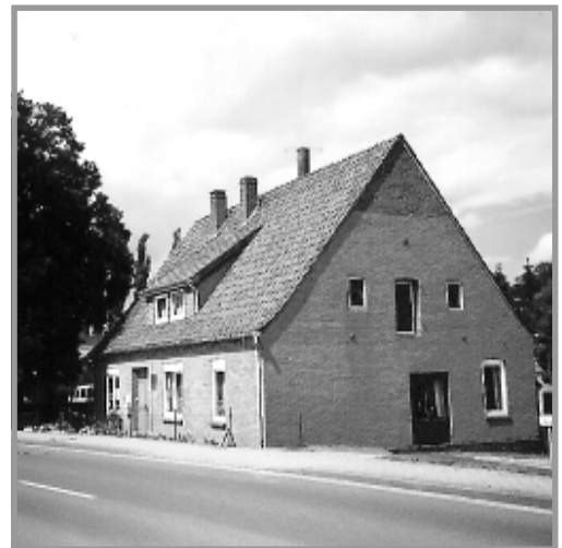
Das Haus in der Osterweder Straße 29.
